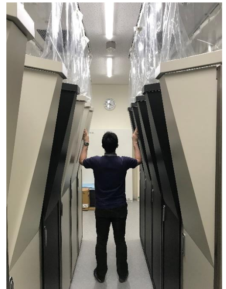
＜ラック室の様子＞
